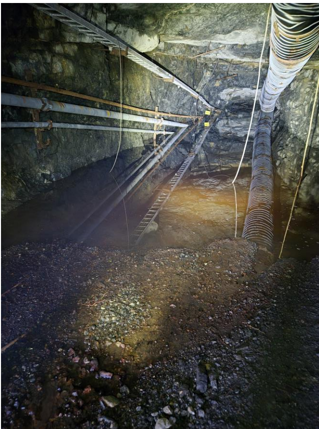
Kuva 20. Tunneli on täytynyt vedellä heti suuaukolta alkaen (13.3.2026).
